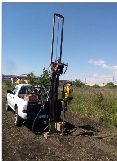
Foto 1. Aspectul terenului investigat cu instalația de foraj geotehnic utilizat.
